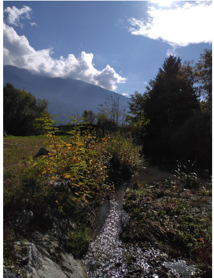
Receppe des ligneux dans les enrochements
