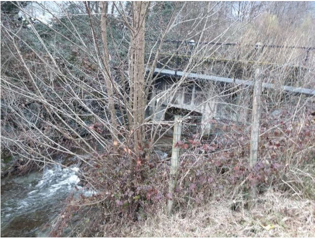
Nettoyage des enrochements recepage
