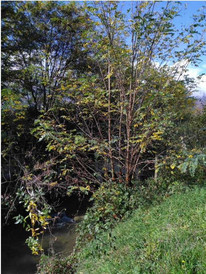
Receppe des ligneux dans les enrochements
