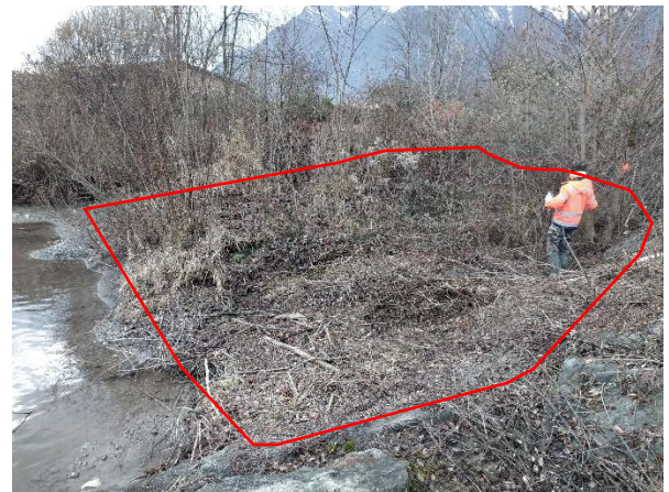
Recépage et ouverture du banc
